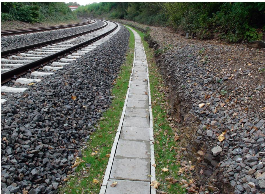
Abb. 11: Kombinierte Entwässerungsanlage, Randweg, belebter Boden
